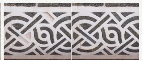
Fig.14ab Integrazione delle tessere mancanti e stuccatura microfratture prima e dopo
