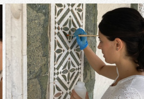
Fig. 12 Consolidamento serpentinite con RC70 + nano particelle di SiO 2 .
