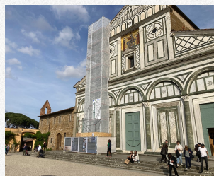
Fig.2 Cantiere studio sulla facciata
