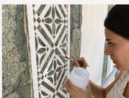
Fig. 11 Consolidamento con nanocalci del marmo
